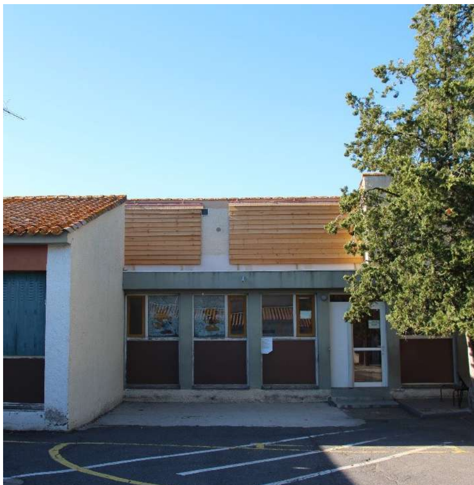
Pose d'un bardage sur une école pour créer des gîtes de repos/transit pour une colonie de Pipistrelles pygmées © Camille Montegu - LPO
