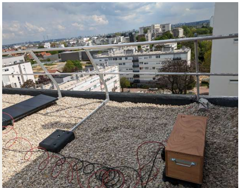
Système de repasse sur le site pilote APHP Saint-Antoine – Paris. © LPO IDF
